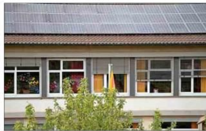
Das erste Projekt von 2013: Die 260 Quadratmeter große PV-Anlage auf dem Dach der Schule.
