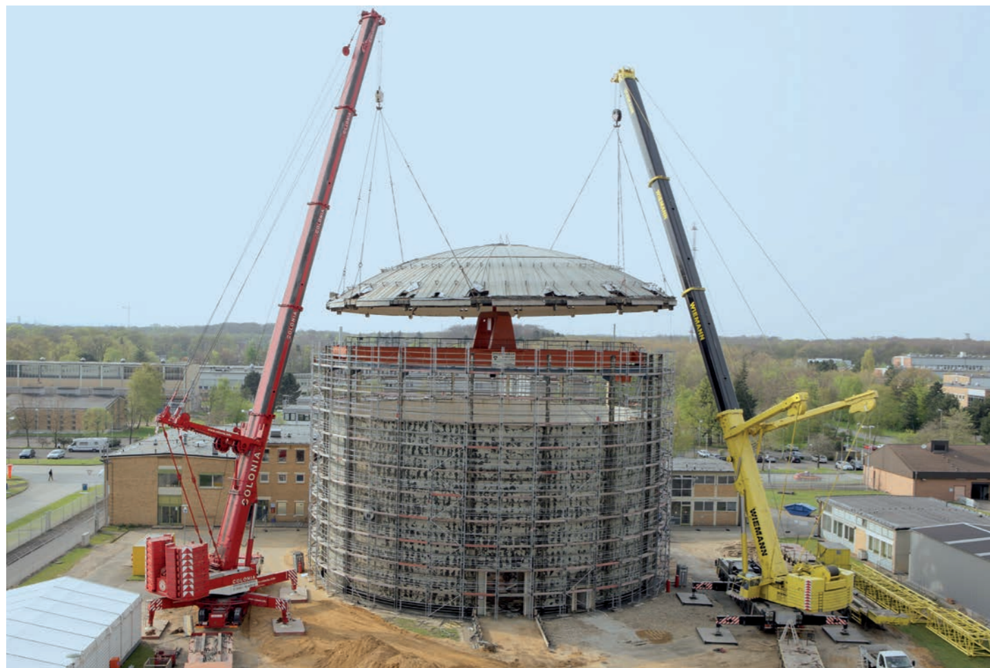
Abb. 7: Abbau des Forschungsreaktors FRJ-1
