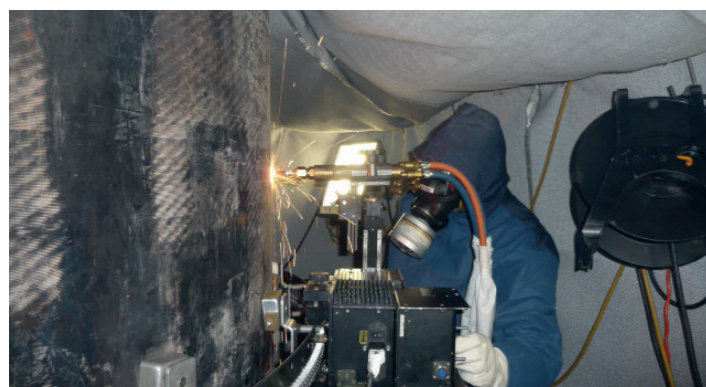
Abb. 28: Manueller Einsatz thermischer Zerlegeverfahren
