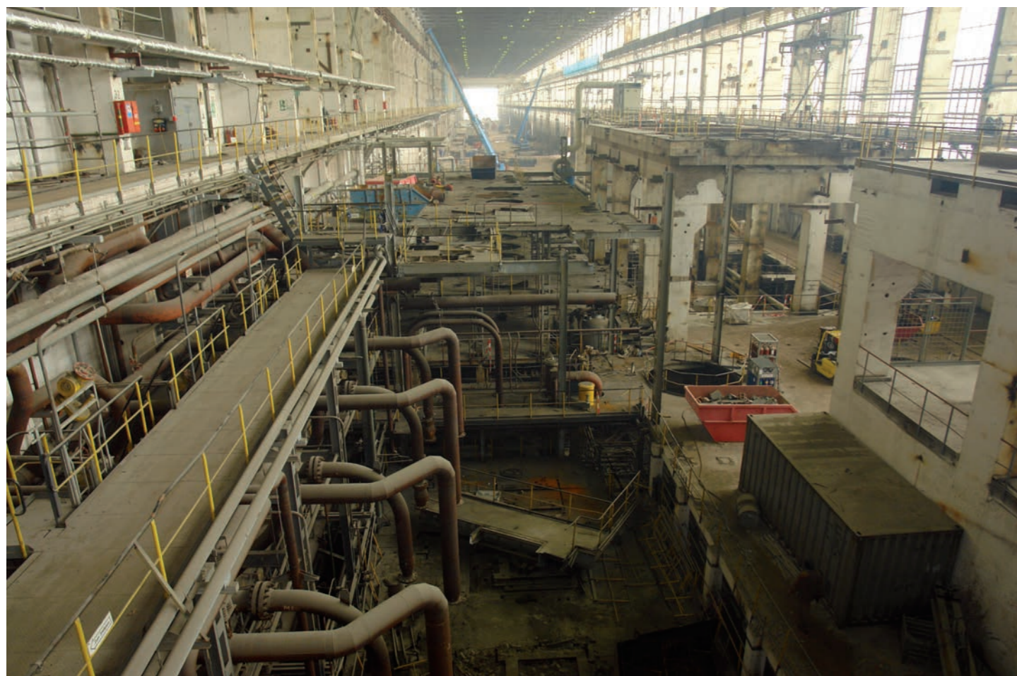
Abb. 43: Maschinenhaus des Kernkraftwerks Greifswald nach der Entfernung der Generatoren
