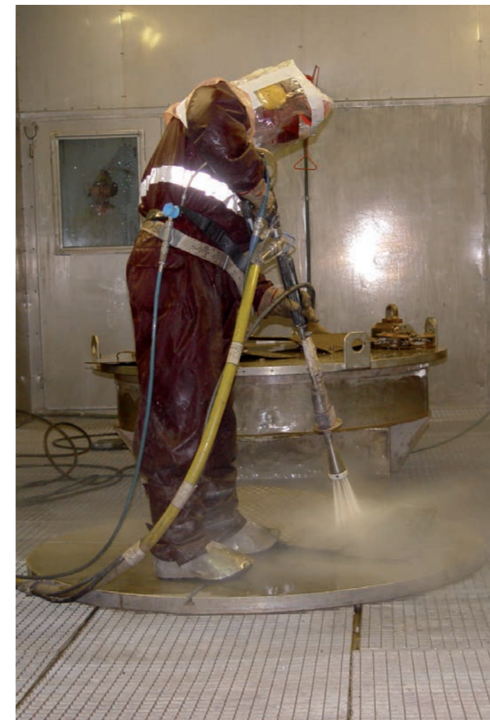
Abb. 24: Vollschutzausrüstung bei der Dekontamination mittels Hochdruckreiniger
