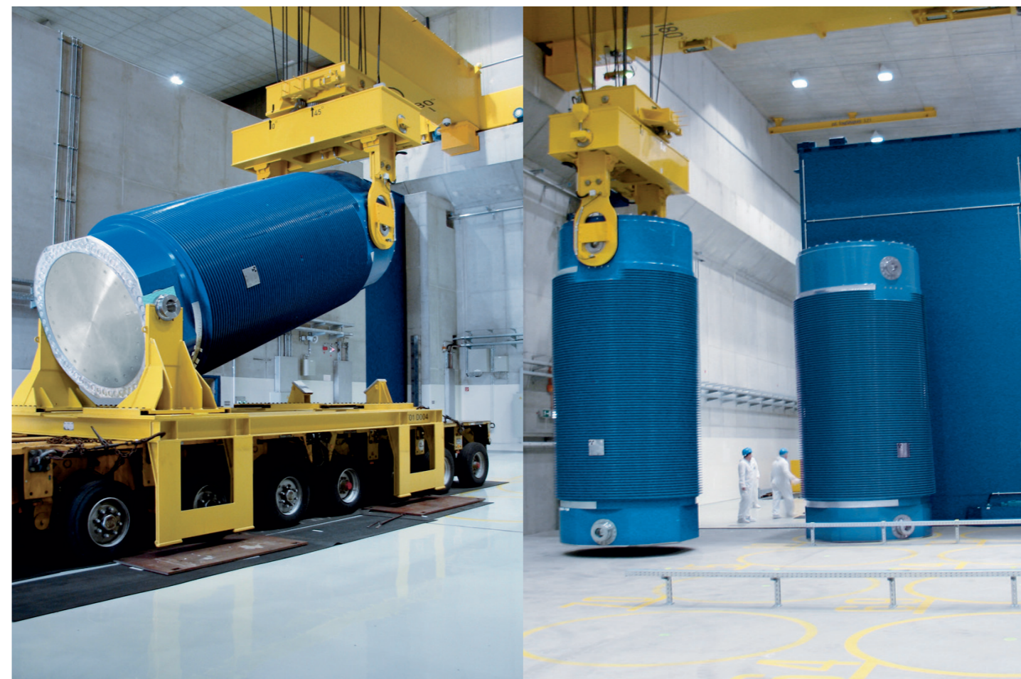
Abb. 42: Einlagerung eines Transportbehälters mit abgebrannten Brennelementen in das Zwischenlager Brunsbüttel
