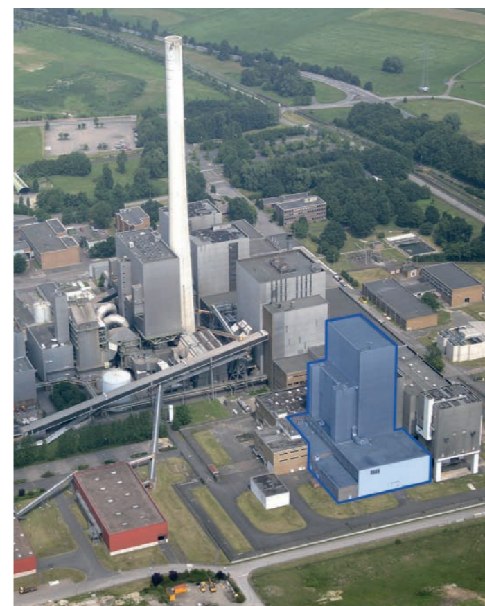
Abb. 11: Gebäude des THTR-300 (Bereich des sicheren Einschluss hervorgehoben)
