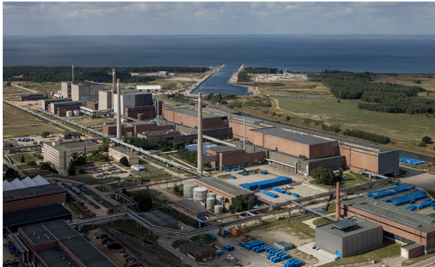
Abb. 2: Standort des Kernkraftwerks Greifswald
