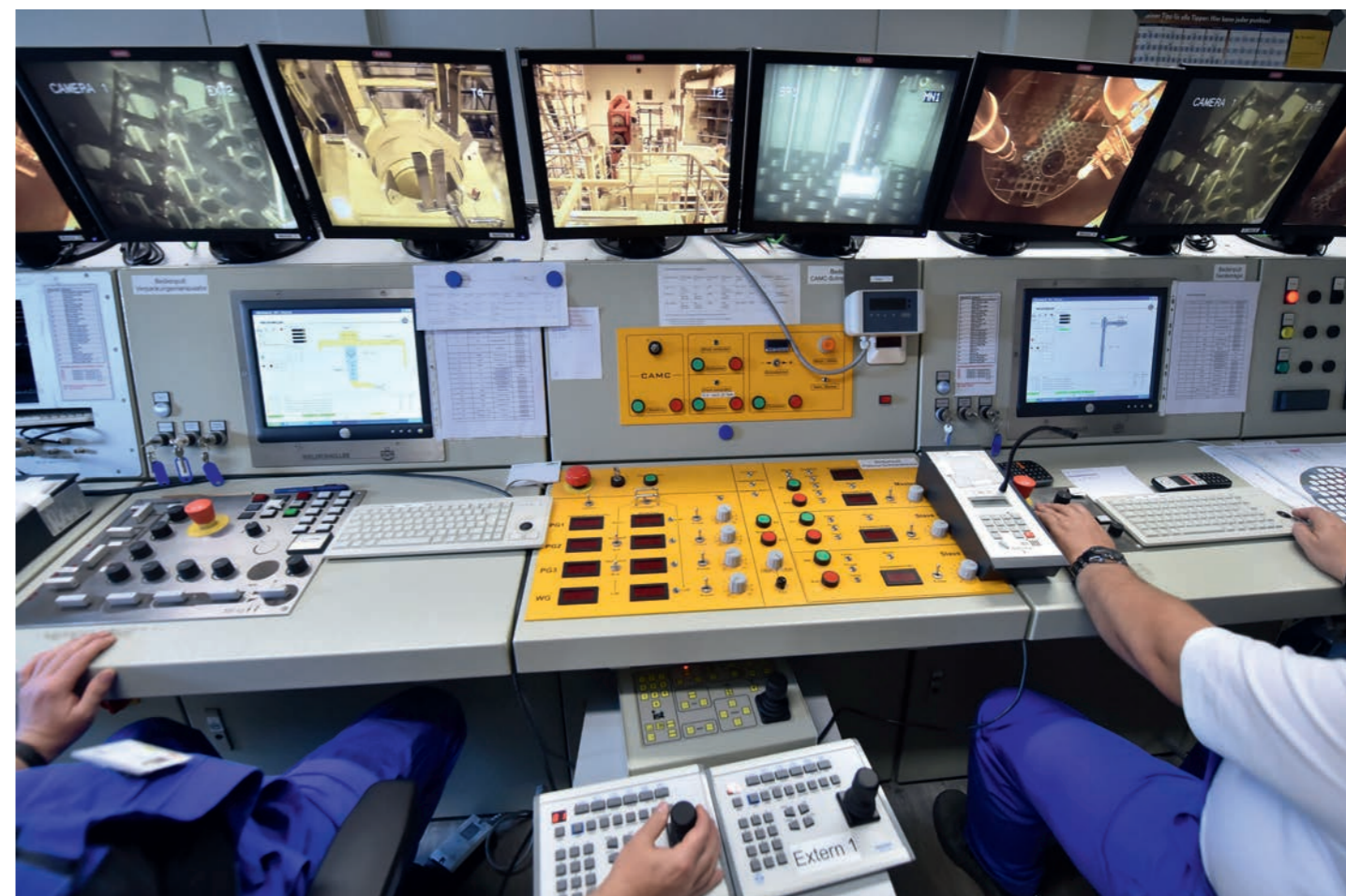
Abb. 44: Leitstand zur fernbedienten Zerlegung im Kernkraftwerk Obrigheim
