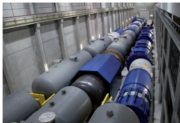
Abb. 40: Abklinglagerung von Großkomponenten im Zwischenlager Nord
