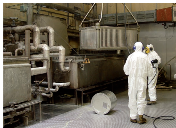
Abb. 25: Chemische Dekontamination
