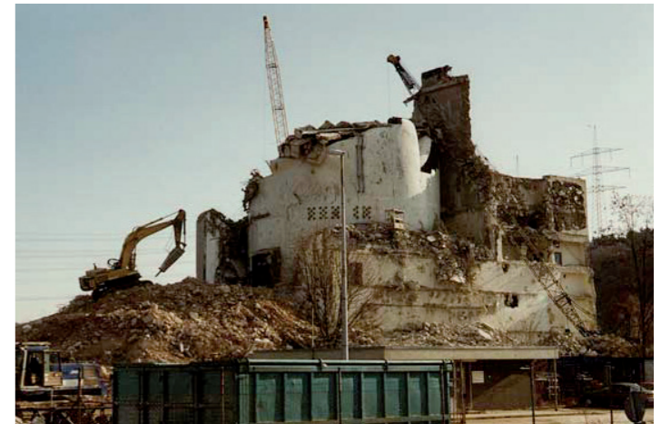
Abb. 17: Konventioneller Abriss der äußeren Gebäudehülle des Kernkraftwerks Niederaichbach
